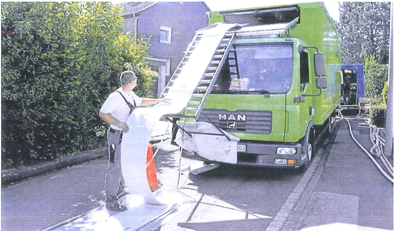
Über ein Rollband wird der Schlauch in das Innere des LKW geführt und dort in einer Spezialmaschine mit Harz getränkt. Am Ende dieses Prozesses kann der Schlauch dann in den Kanal eingelassen werden.
