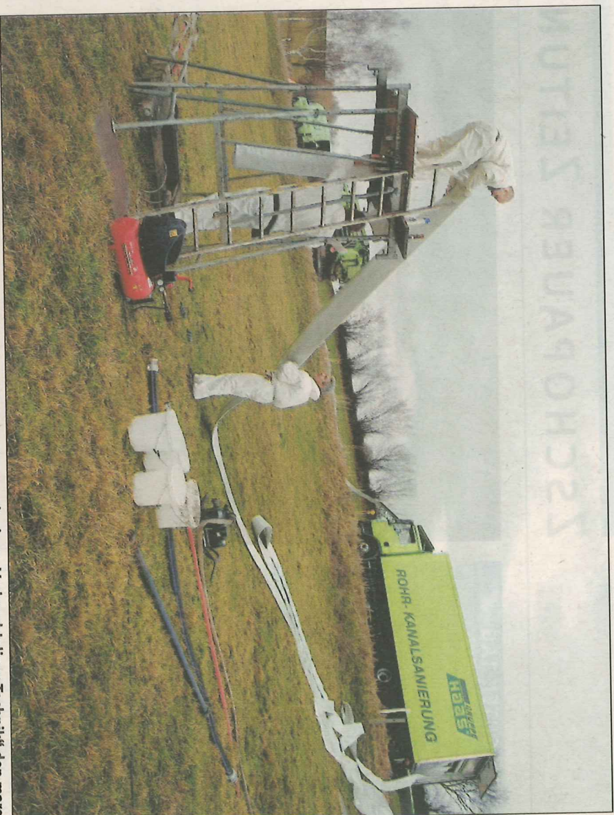
Mitarbeiter der Chemnitzer Niederlassung der Firma Haas sanieren mit einer „Verbund-Inliner-Technik“ den maroden Sammler. Nach dem Befüllen des Mantels wird das noch weiche Rohr in den Schacht eingeführt. Von links: Michael Krüger, Marco Krieger und Wolfgang Hadrion.
