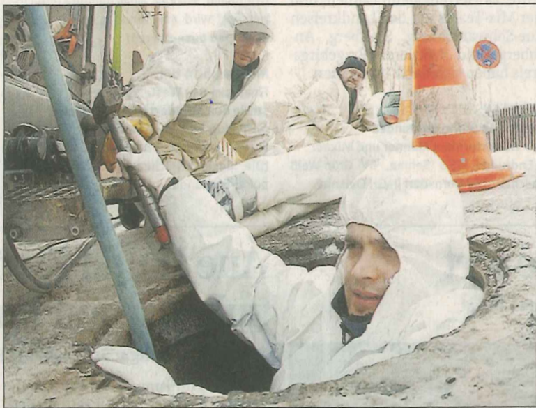
Michael Krüger (vorn), Bernd Bacher (links) und Matthias Medicke bei der Sanierung des Kanals unter der Auer Eisenbahnstraße. -FOTO: MARCEL WEIDLICH
